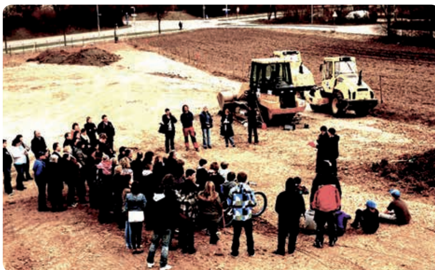
Der Bau kann beginnen: Jugendliche und Mitwirkende auf dem Gelände des künftigen Dirtparks. Foto: Jugendgemeinderat Filderstadt
